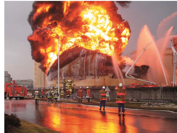
上図：平成15年十勝沖地震による屋外タンク火災
